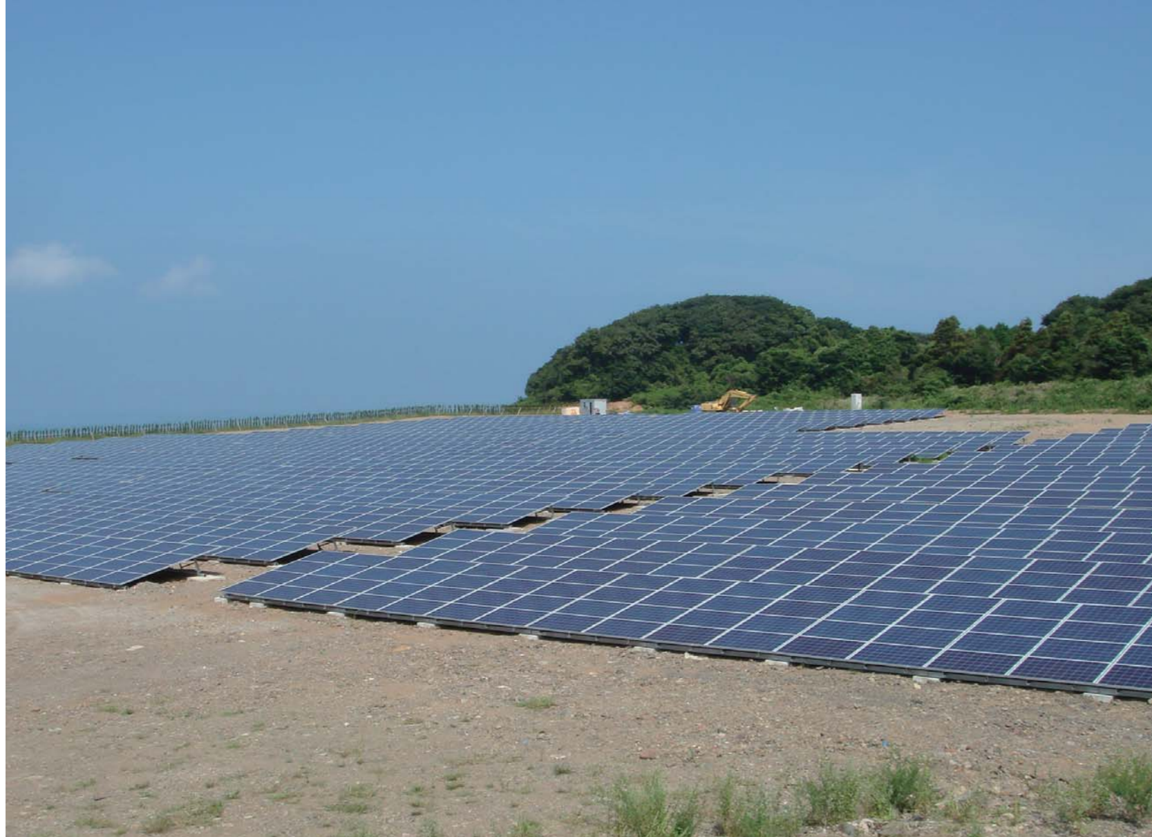
Saikai Nagasaki, Japan, 2 MW, Bodenmontage, Juli 2013
