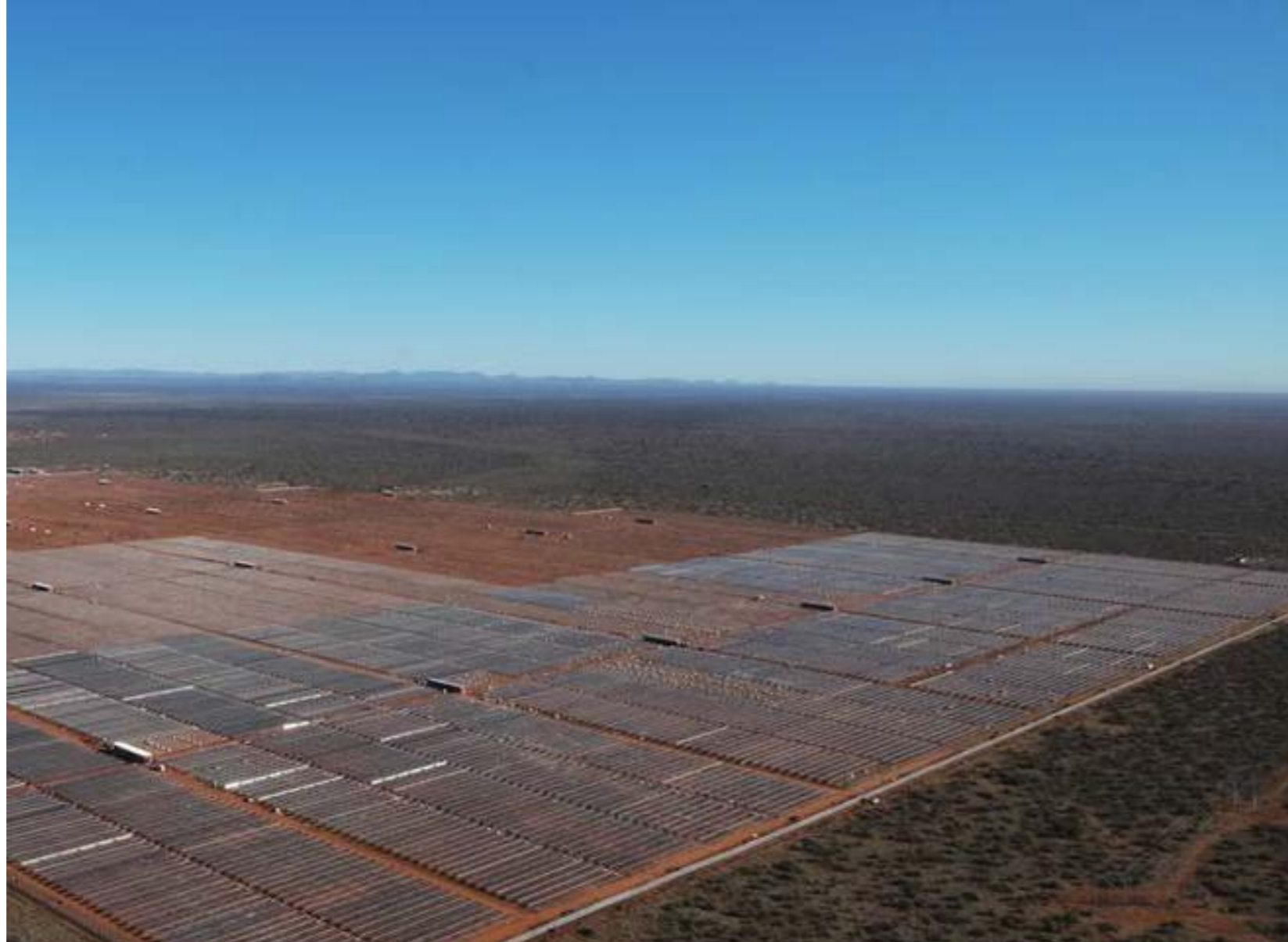
Kapstadt, Südafrika, 81 MW, Bodenmontage, Juni 2014
