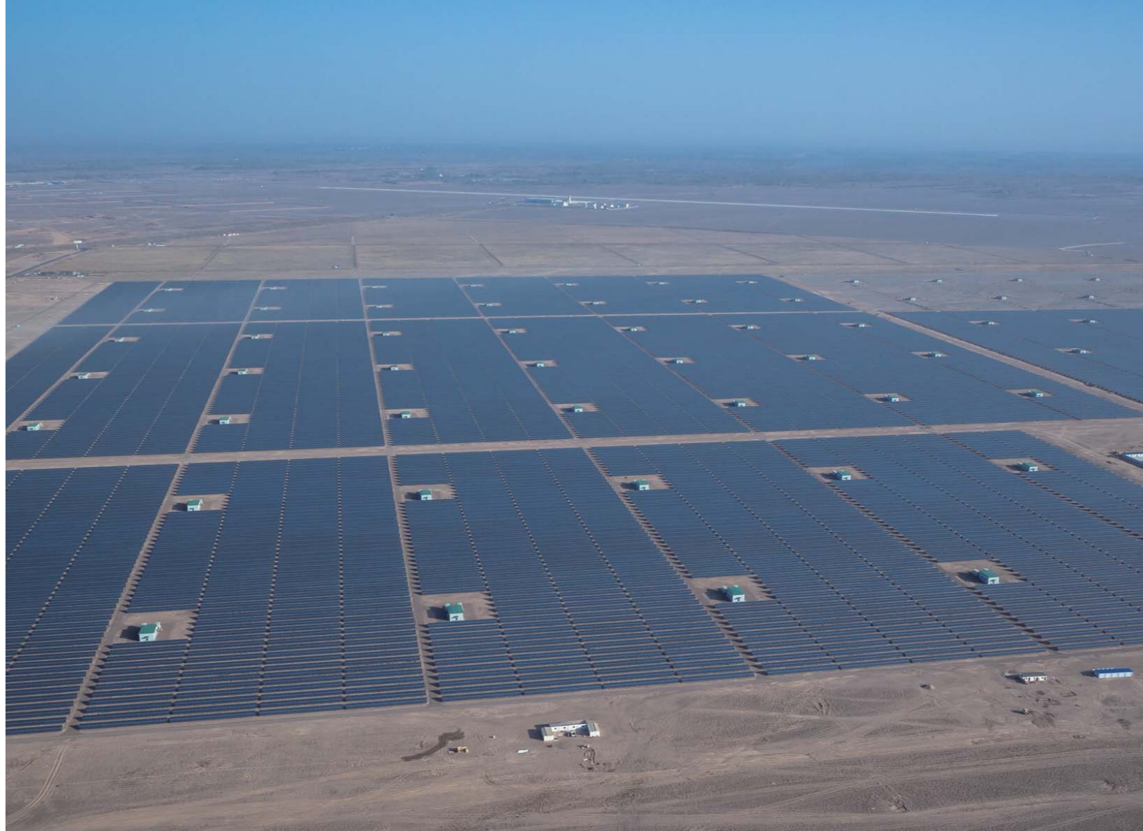
Gansu JinChang, China, 200 MW Bodenmontage, Dezember 2013
